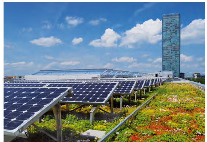
Abb. 55: Kombination aus Dachbegrünung und PV-Anlage, Nürtingen [DQ3]
