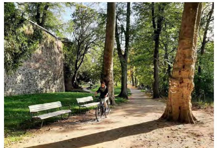
Abb. 62: Fußweg mit wassergebundener Wegedecke, Offenburg [3]
