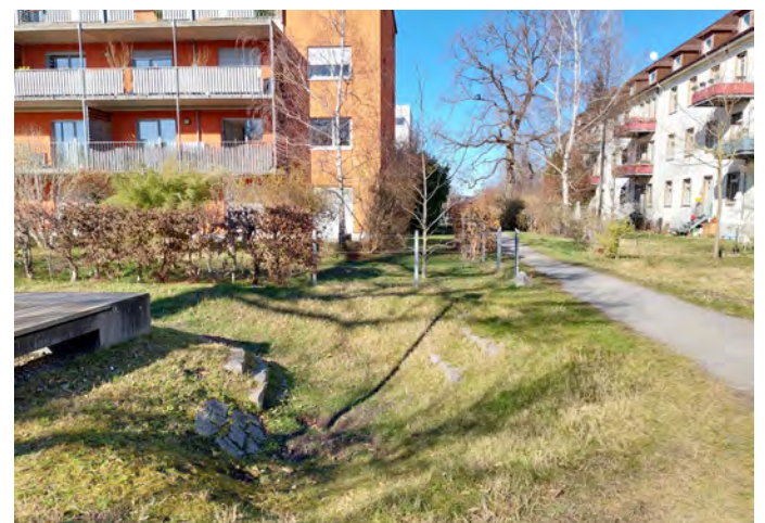
Abb. 44: Versickerungsmulde auf einer Grünfläche, Karlsruhe [1]
