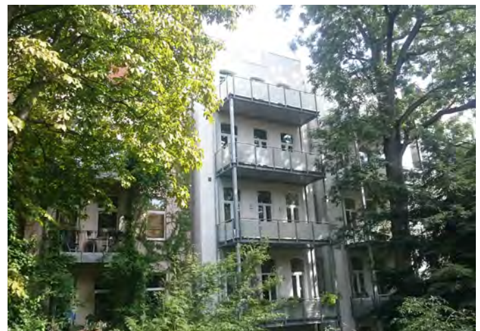
Abb. 57: Gebäudeverschattung durch Bäume, Hannover [2]
