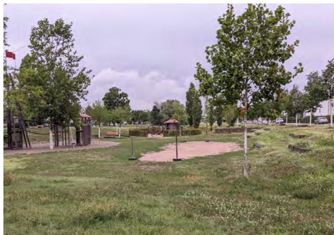
Abb. 43: Freiraum mit Retentionsfunktion, Karlsruhe [1]
