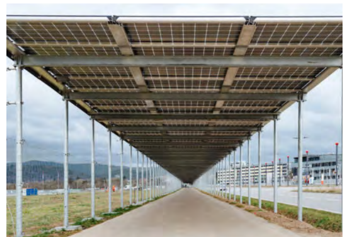
Abb. 64: technische Verschattung eines Radwegs. Messe Freiburg [3]
