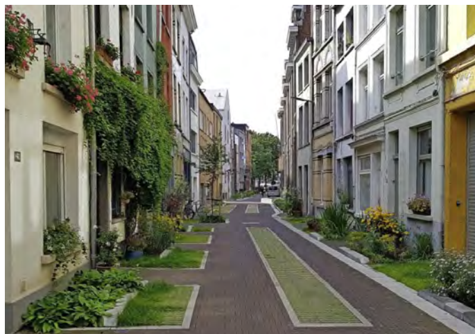
Abb. 61: Entsiegelter Straßenraum, Antwerpen [3]
